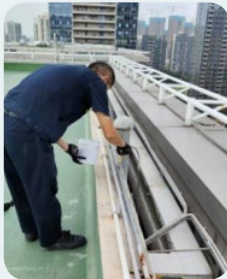
屋面弱电管线检修
