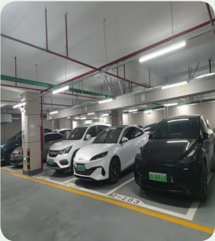
升级照明系统前
